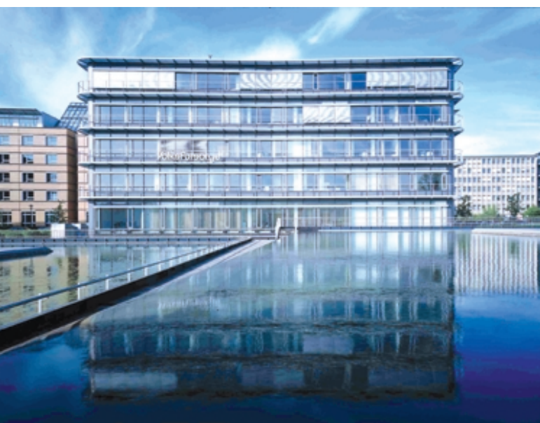
Hafenstraße in Saarbrücken Bild: AGIV Real Estate
