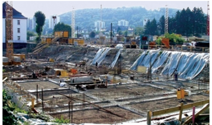
Solides Fundament als erster Baustein
