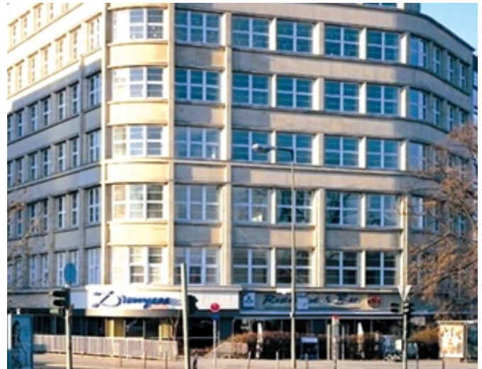
Büro- und Geschäftshaus in der Potsdamer Straße/Berlin Bild: POLIS
