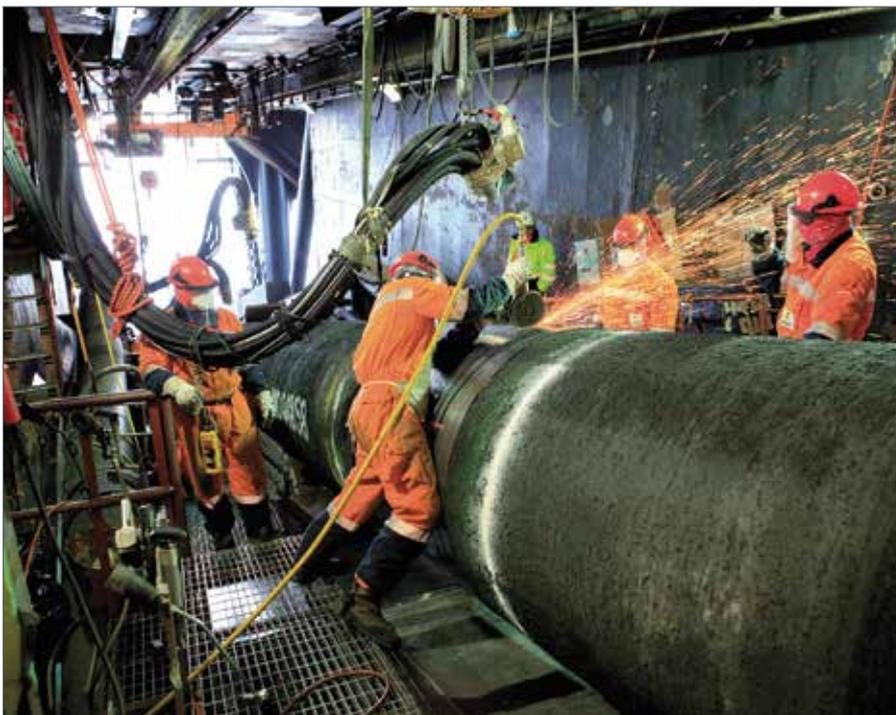
Bevor die Pipeline auf dem Meeresboden abgelegt wird, werden die Rohre auf dem Verlegeschiff an den Strang geschweißt
