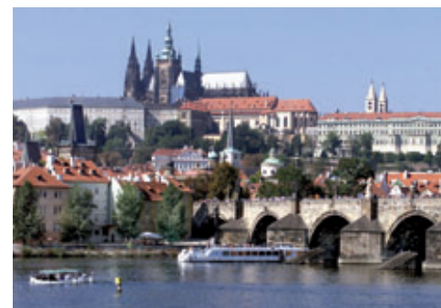
Für die Expansion in den osteuropäischen Raum ist Zentiva hervorragend aufgestellt
