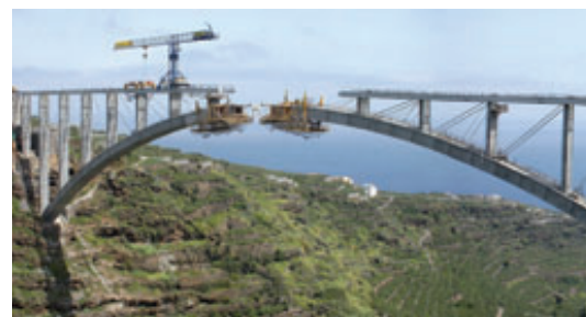
Ferrovial Arco de Los Tilos: Spaniens Baukonzerne streben nach mehr; Quelle: Ferrovial
