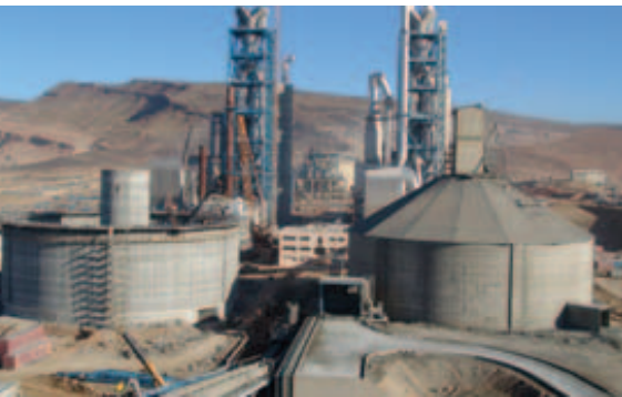
Erweiterung der Zementfabrik von OCI in Algerien
